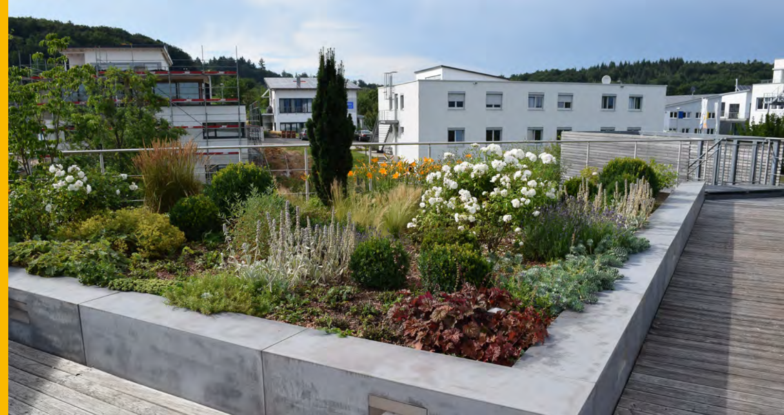
Dachbegrünung als sommerlicher Wärmeschutz für Innenräume © Nürtingen_Zinco
