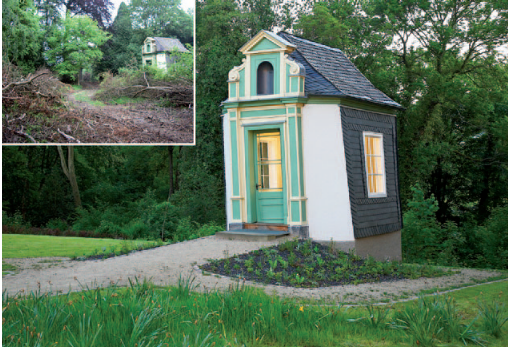
Abb. 22: Gartenhäuser vor und Nutzung nach der Sanierung
