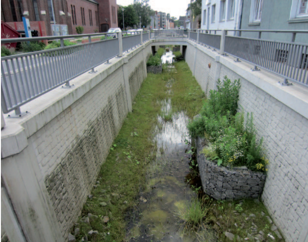
Abb. 32: Öffnung des Deininghauser Baches, Castrop-Rauxel
