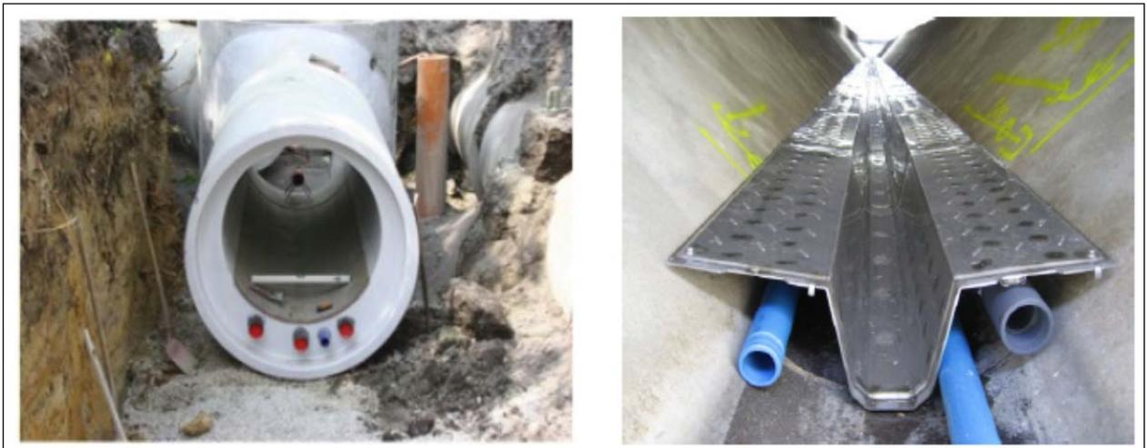
**Abbildung 102: Werksseitig integrierter Wärmetauscher (links, Quelle: Wallstein Ingenieur GmbH) und vorgefertigter, nachträglich eingebauter Tauscher (rechts, Quelle: Uhrig Straßen-Tiefbau GmbH)**
