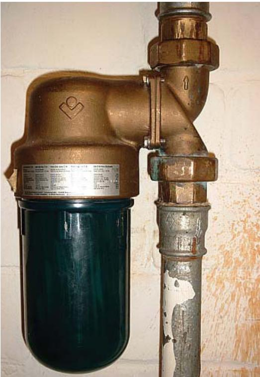
**Eingangswasserfilter zur Rückhaltung von Partikeln, die aus dem zentralen Versorgungsnetz angeschwemmt werden.**
